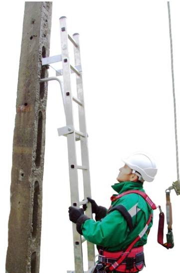
1. A kampó beakasztása a legfelső áttörésbe
