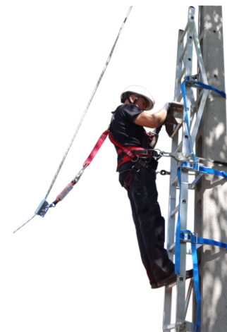
8. Kép :Második létraelem rögzítése
