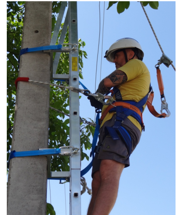
4. Kép :Második létraelem rögzítése
