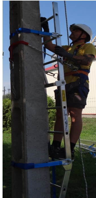
2. Kép :Első létraelem rögzítése
